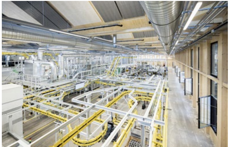
Produktionshalle der V-ZUG mit der Emallierungsanlage (Hochtemperaturprozess) für Backöfen
